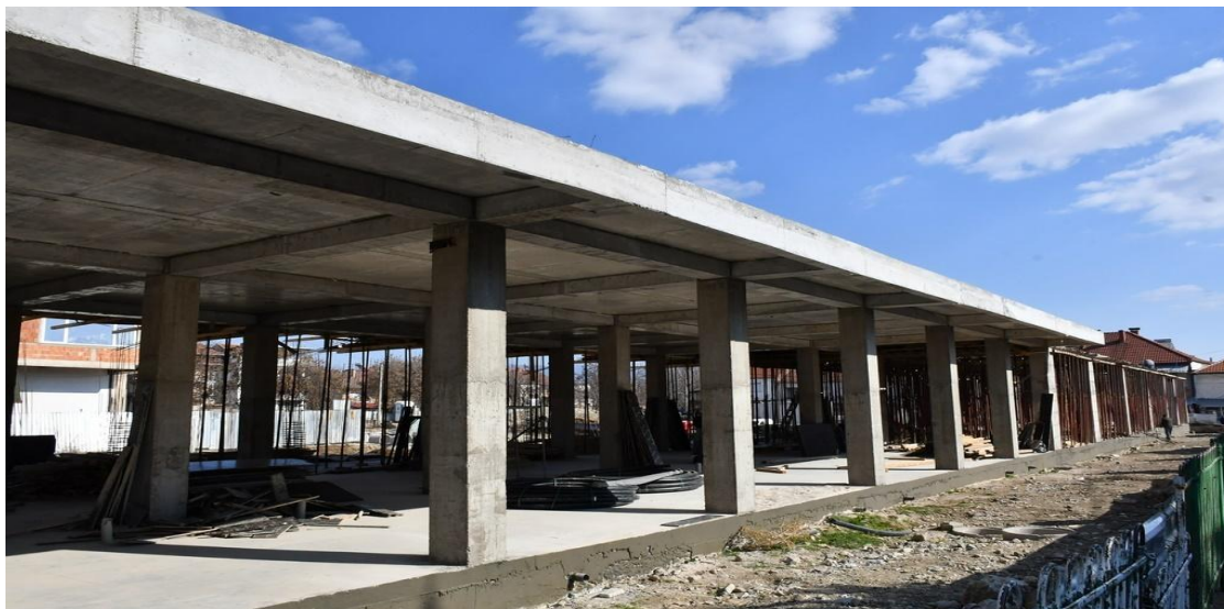
Слика 5. Изградба на Градски пазар
