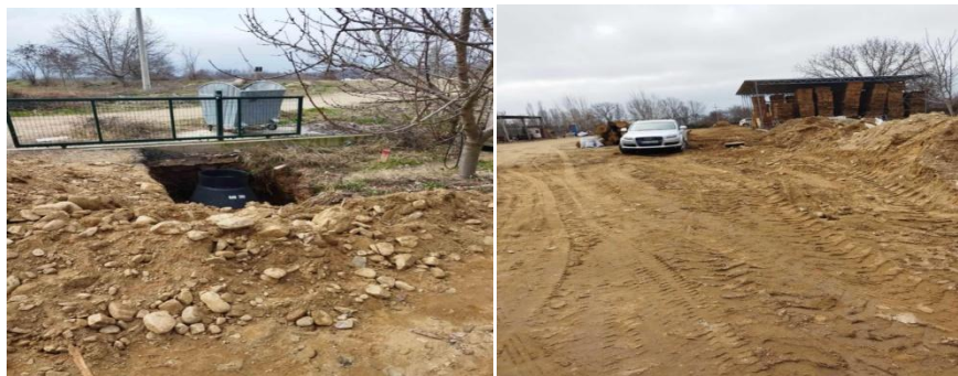
Слика 4. Изградба на фекална канализациона мрежа во м.в. Карши Маале во с. Подареш
